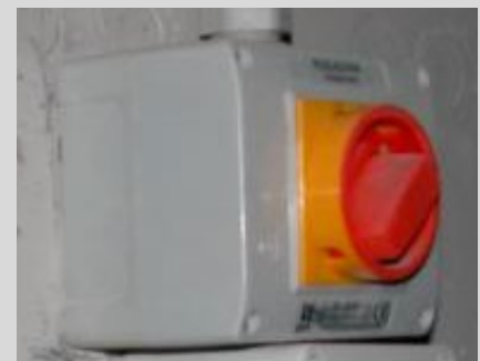
Abb. 3 Beispiel für einen Hauptschalter (abschließbar in der Aus-Stellung durch Vorhängeschlosser)
